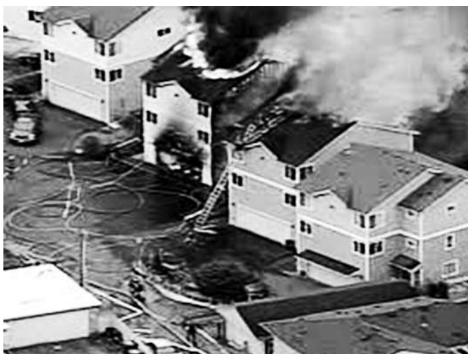
Hình 3.2. Cháy từ nhà bên cạnh
